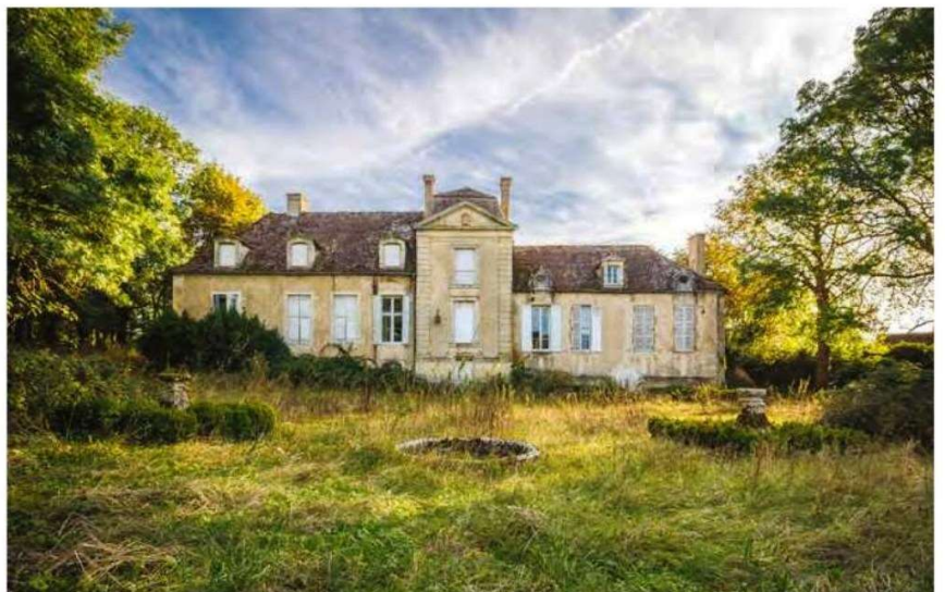
↑ UN ÉNORME CHANTIER Toitures, boiseries, plomberie, le château devra être rénové du sol au plafond avant d'être vivable.
