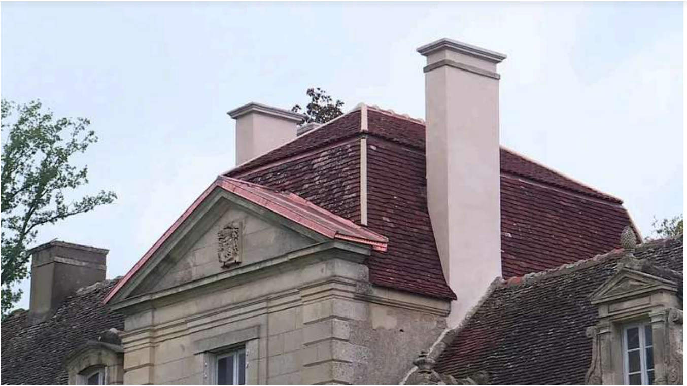
La partie de la toiture du château d'Annéot (Yonne) refaite en 2025. ● © LOUIS MALLEJAC / FRANCE TÉLÉVISIONS
